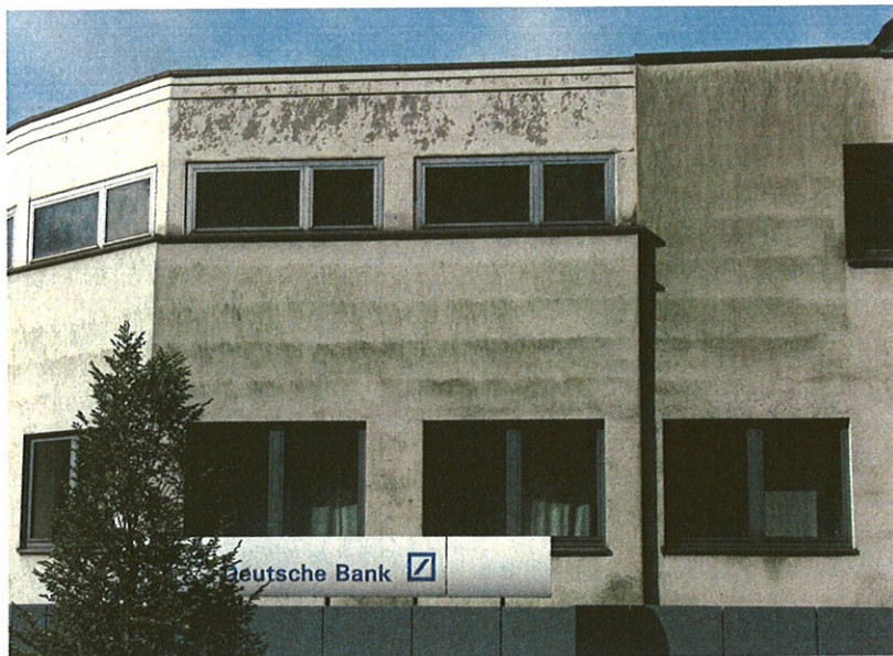
3 Vergraute, veralgte und oder verpilzte Fassaden sind wahrlich kein schöner Anblick. Und bisweilen schädigen die Mikroorganismen regelrecht die Bausubstanz. In vielen Fällen wäre ein angemessener architektonischer Entwurf, zum Beispiel ein ausreichend großer Dachüberstand, bereits ein großer Schritt hin zur Lösung des Problems. (Foto: Gabriel)
